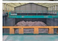
新最終処分場 屋根付の最新鋭の最終処 分場で外部への埋立物の飛 散や臭気による環境への悪 影響が無く、雨や雪の天候 にも影響されることも無い との説明。
